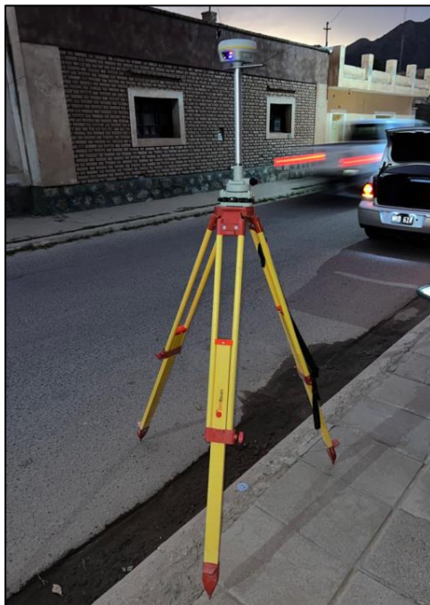
Figura N°20. Punto fijo colocado en la mitad de la cuadra.
