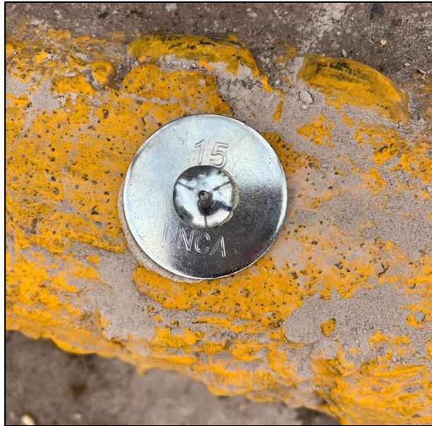
Figura N°16. Fotografía de la monumentación del punto fijo 15.
