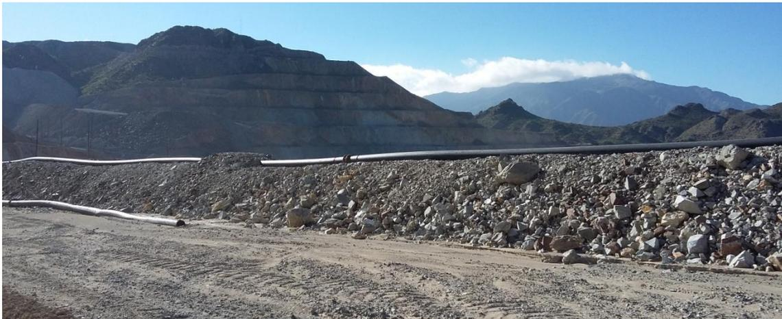
Foto 9. Camino de alto tránsito entre el sector de chancado de material y el Open pit (sector de voladuras y movimiento de material). Botaderos a los costados del camino
