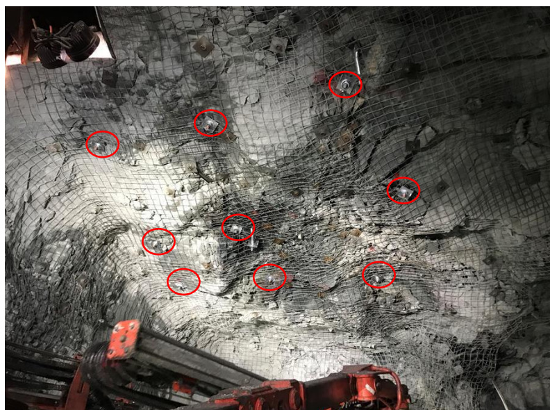
Imagen N°3: EM_355GTE-EV040. Pernos MDX instalados en corona
