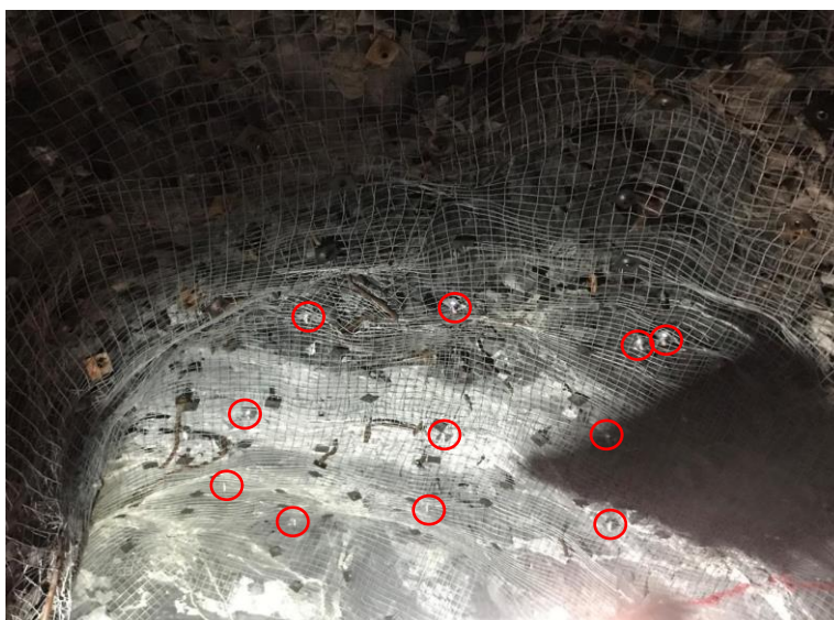
Imagen N°5: MC_300RP-EC576. Pernos MDX instalados en corona
