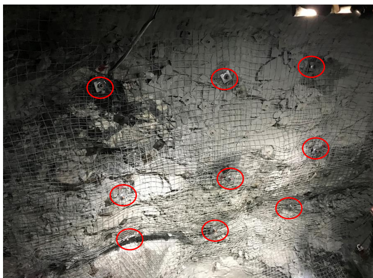
Imagen N°4: EM_355GB-Cx033. Pernos MDX instalados en corona
