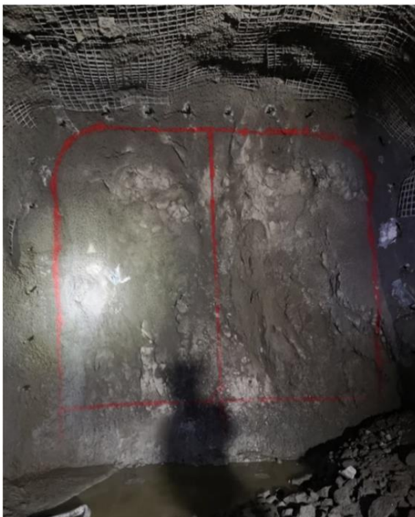
Imagen N°1: Fortificación tipo spilling
