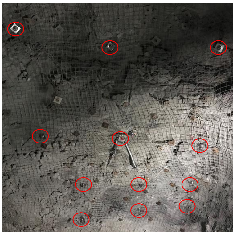
Imagen N°2: EM_355GTE-CX039. Pernos MDX instalados en corona
