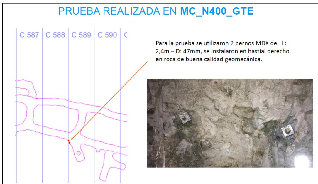
Figura N°46: MC_400GTE. Ubicación Prueba anclaje mecánico
