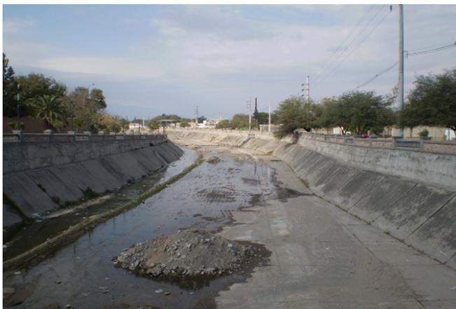
Vista del arroyo Fariñango recubierto con muros de hormigón armado.
