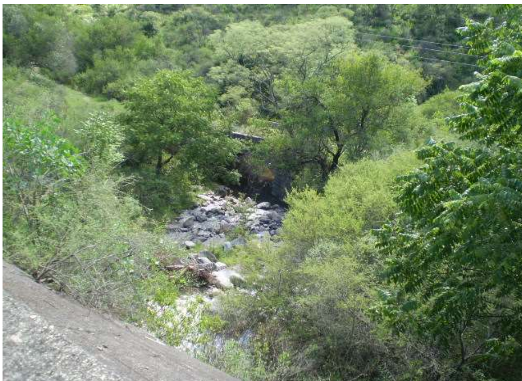
Puente sobre el Río Los Pinos. Fuente F.R. Palacios
