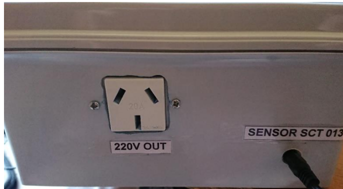
Figura 5-5 - Conexión del aire acondicionado de repuesto y sensor SCT013
