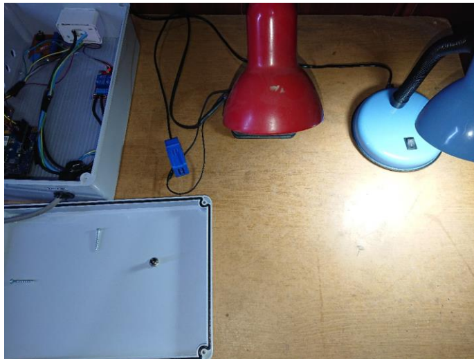
Figura 5-26 - Prueba de Sensor de Corriente SCT-013-000, Apagado
