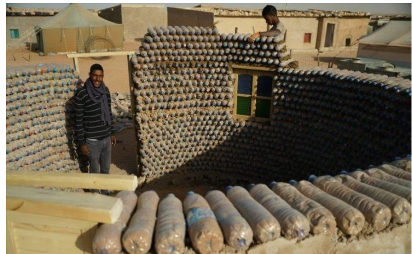
Campo de refugiados Dadaab- Kenia. 402.361 habitantes. Arquitectura con botellas de plástico y arena. Campo de refugiados saharauí. Tinduf, Argelia. Ing. Tateh Lehib Braica. F Internet.
