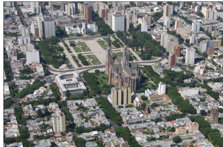
Tensiones urbanas. Catedral y Palacio Municipal. Plaza Moreno. Eje Monumental de La Plata. F Internet.
