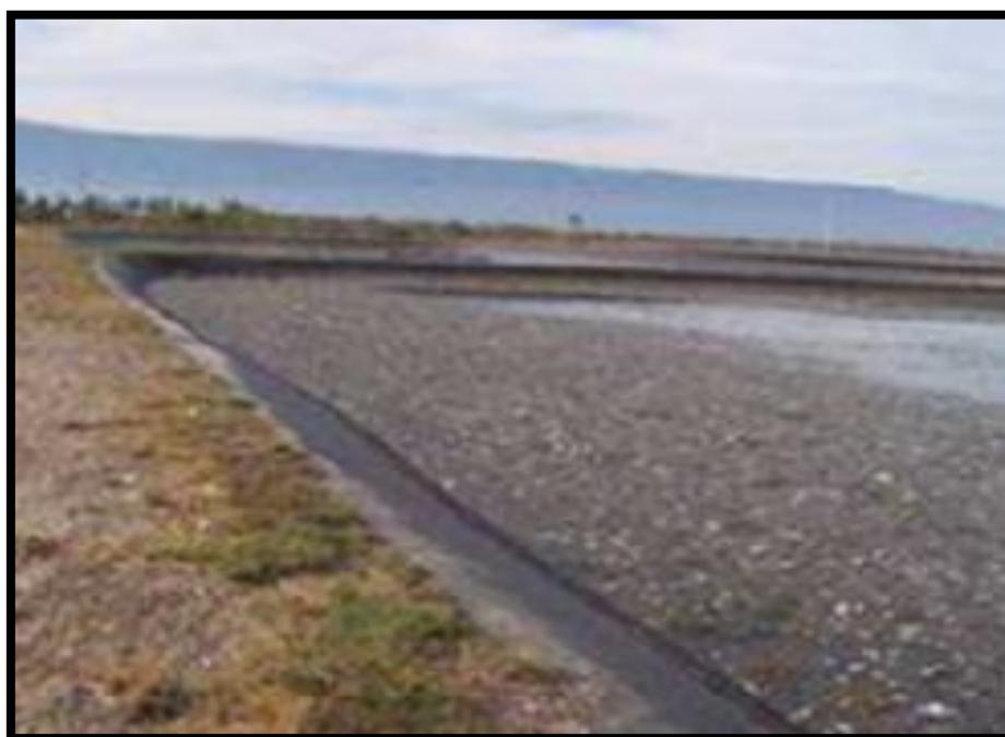
**Figura Nº 26:** Sólidos flotantes en laguna anaeróbica. Fuente: Saracho, M. et al. (2008).
