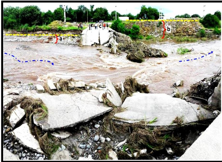
**Figura Nº 21:** Diferencia de altura de los taludes (a-b) correspondiente a la profundidad de socavación vertical del río del Valle en badén de la Virgen. Fuente: Costello, M.
