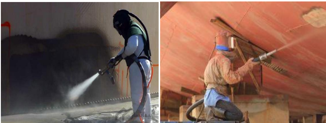
Figura 37 - Chorreado abrasivo.
