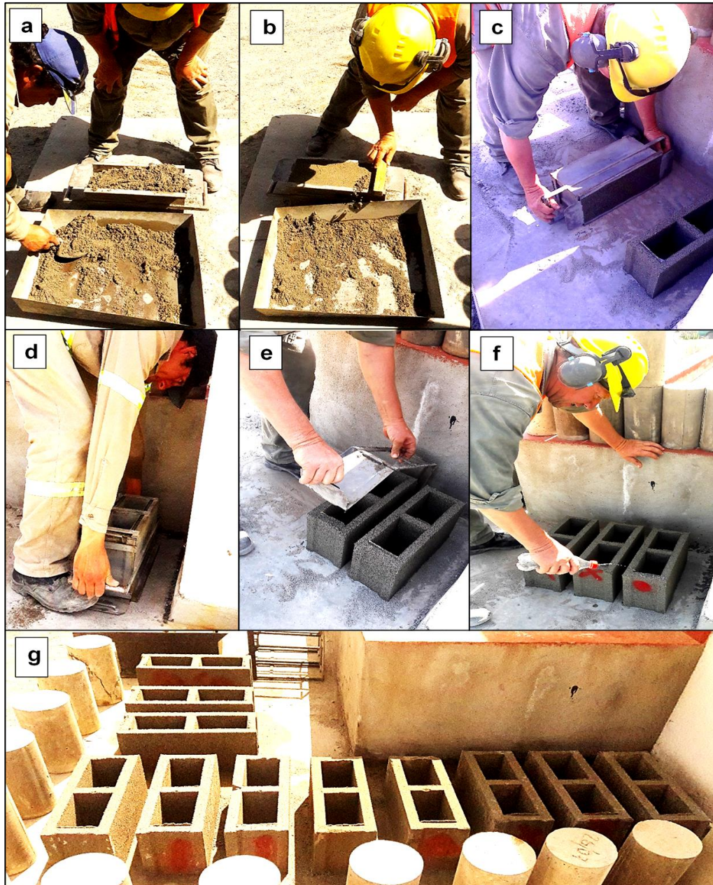
Foto N° 20 – Proceso de elaboración de los bloques de hormigón. (a) y (b) Llenado y compactado del molde. (c), (d) y (e) Proceso de desmolde del material. (f) Humedecimiento de los bloques elaborados. (g) bloques terminados en cantera.
