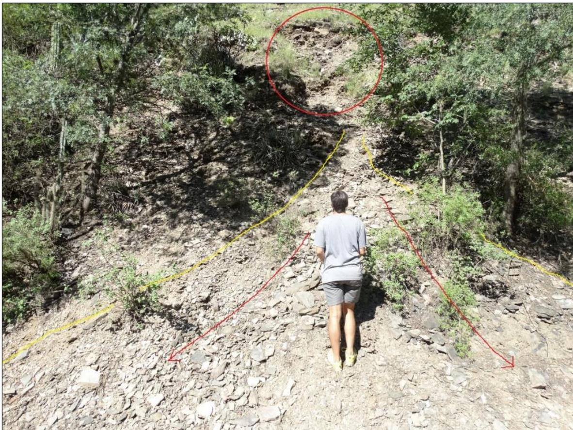
**Fig.36-** *Deslizamientos de tierra próximos a la huella del camino con el material removido*
