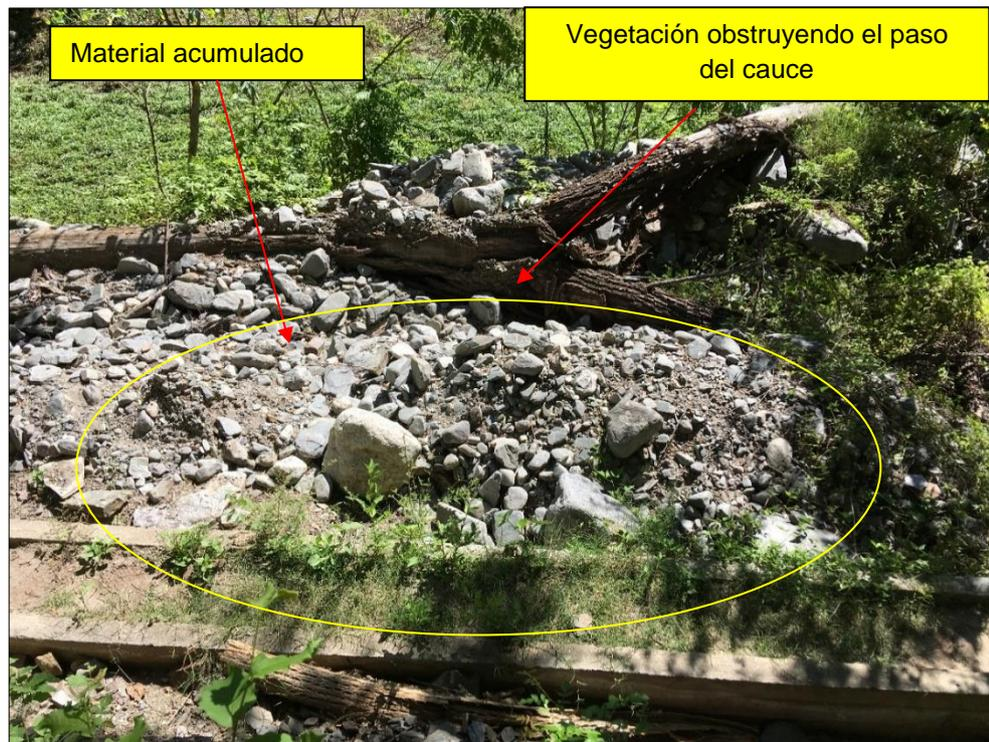
**Fig.62-** Material depositado en el lecho del cauce, generando taponamiento del canal colector
