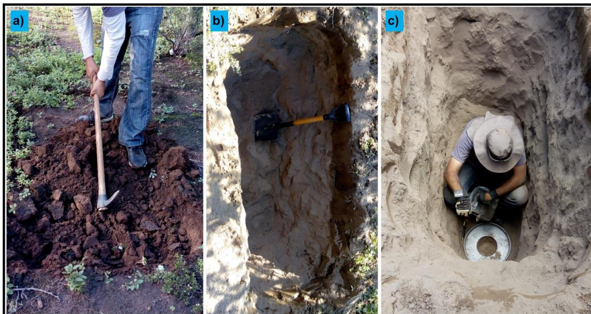
Foto 13: a) Demarcación de la calicata b) Calicata en desarrollo c) Calicata finalizada.
