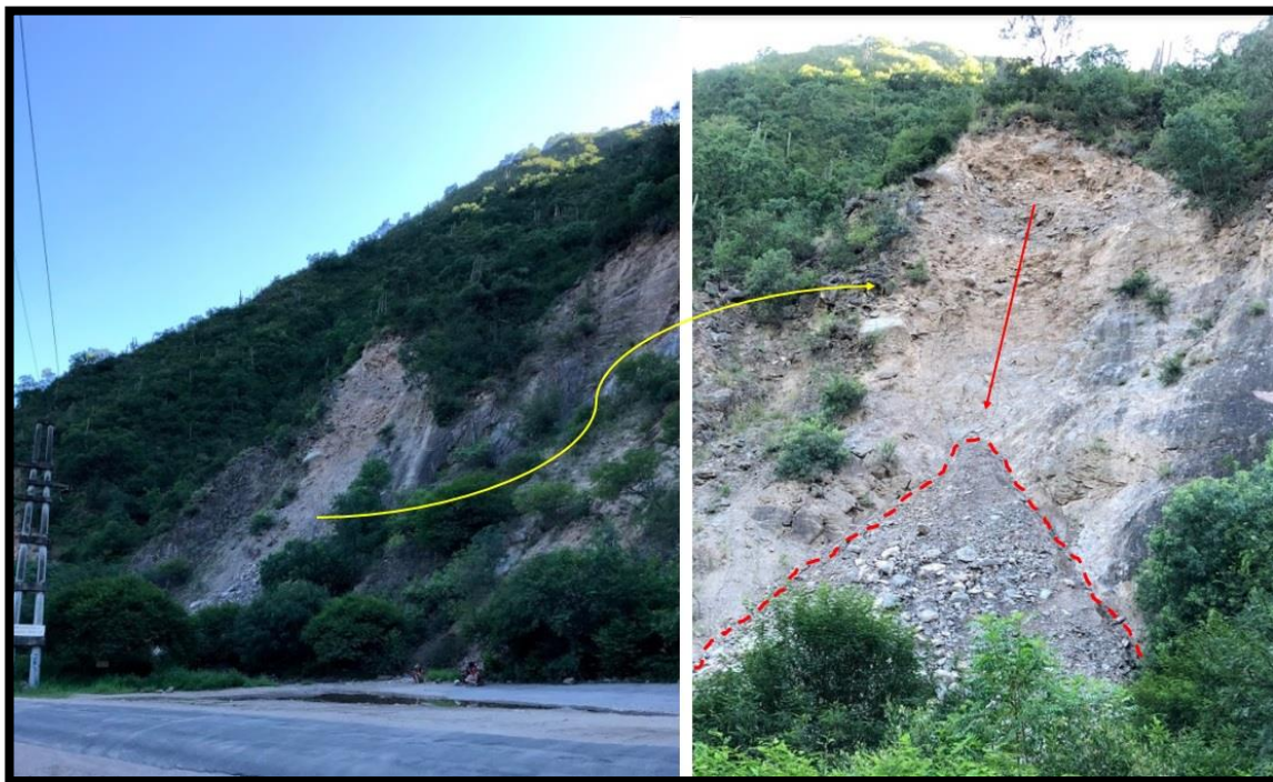
Fotografía 17: Uno de los deslizamientos de grandes dimensiones en el lado este de la Ruta Provincial N°4. Material de deslizamiento del tipo grueso medio y fino.
