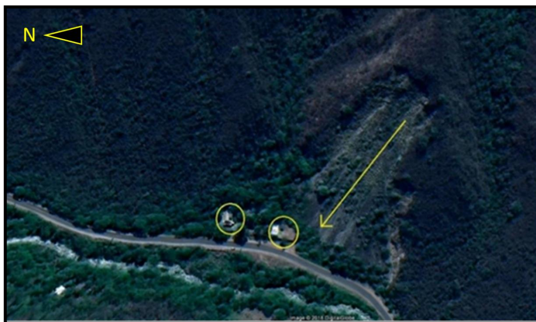
Figura 26: Deslizamiento de ladera en la microcuenca N° 6.
