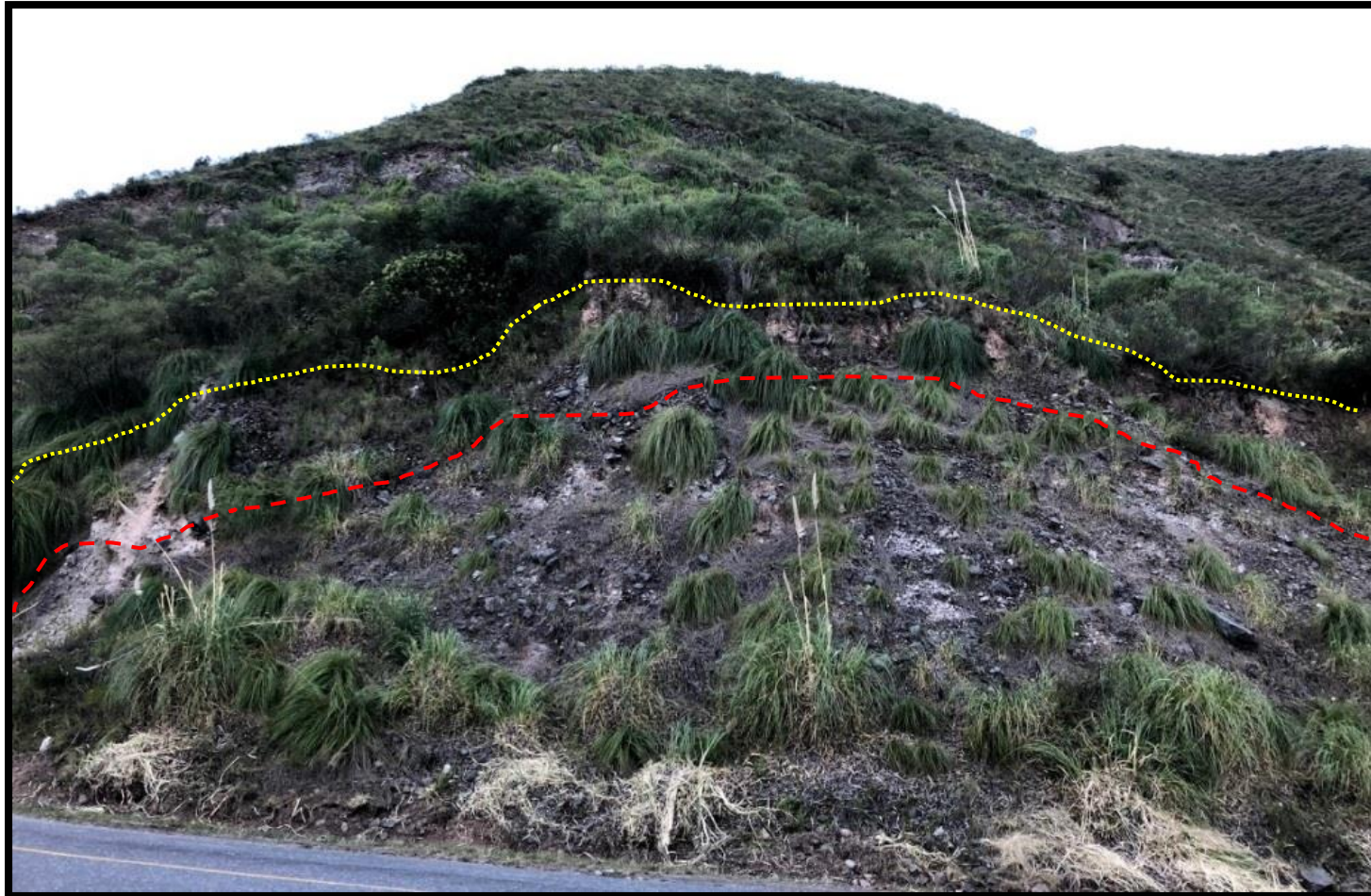
Fotografía 21: Fotografía que representa la figura N° 52. En línea de puntos la cicatriz de deslizamiento y en línea de rayas el material deslizado.
