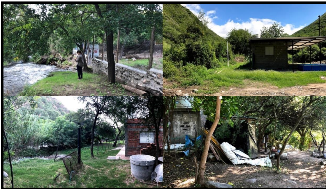
Fotografía 23: Se muestran las edificaciones nuevas y los asentamientos que se ubican a la vera del cauce principal.
