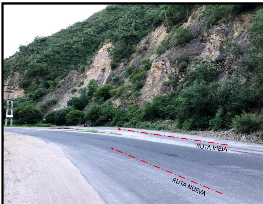
Fotografía 18: Debido a los derrumbes continuos capturados en la Fotografía N° 17 esto produjo que la ruta que pasaba en el piedemonte se corriera unos metros más hacia el oeste.
