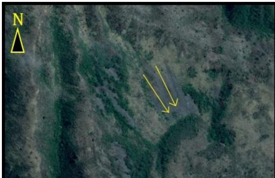
Figura 25: Deslizamiento de ladera en la microcuenca N° 5.
