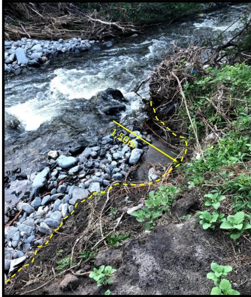
Fotografía 8: Avance del río principal.
