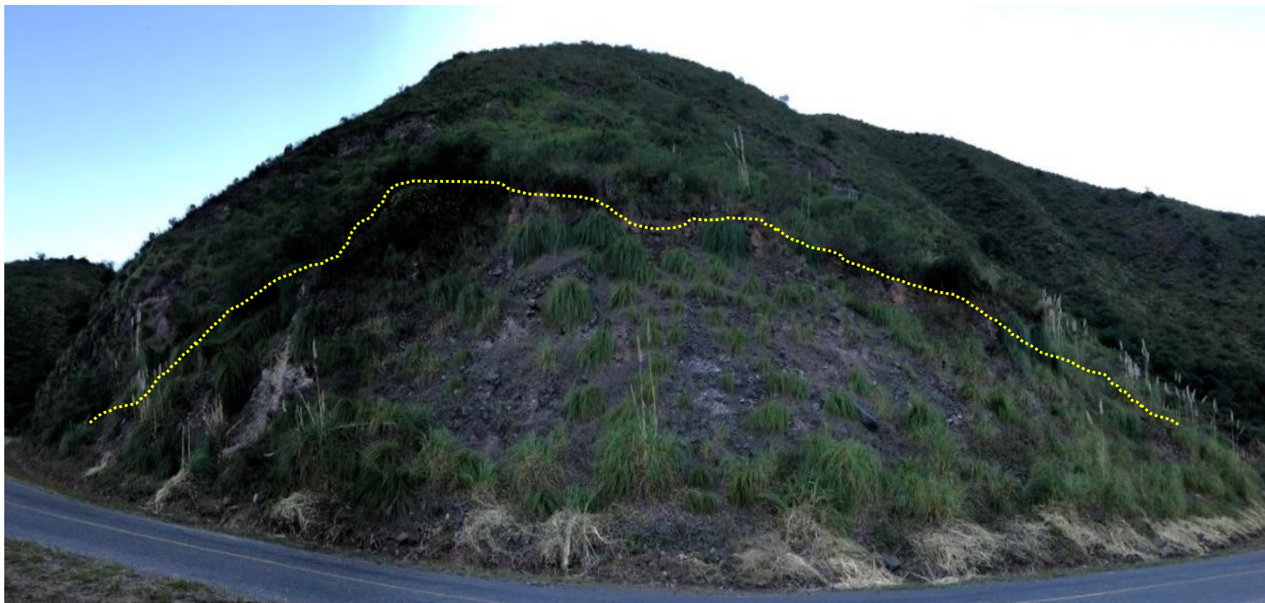
Fotografía 20: Fotografía que representa la captura de la figura N° 51. En línea de puntos la cicatriz del deslizamiento.
