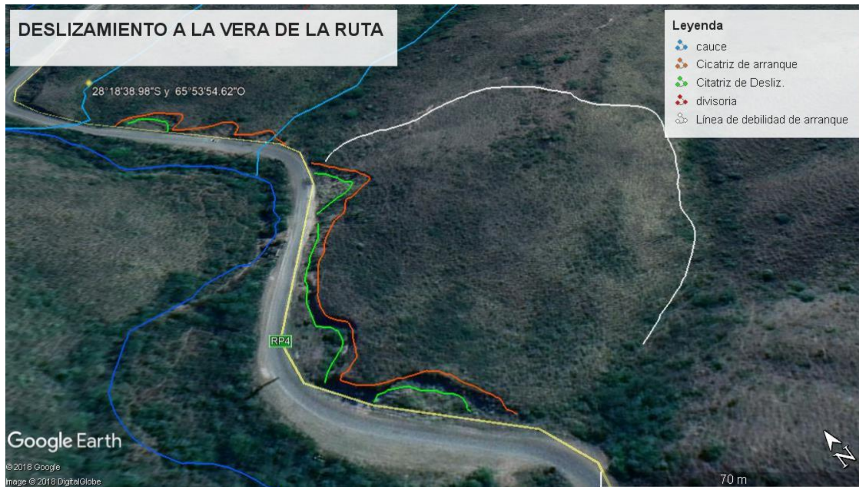
Figura 51: Deslizamientos de laderas en la zona cumbre de la subcuena media.
