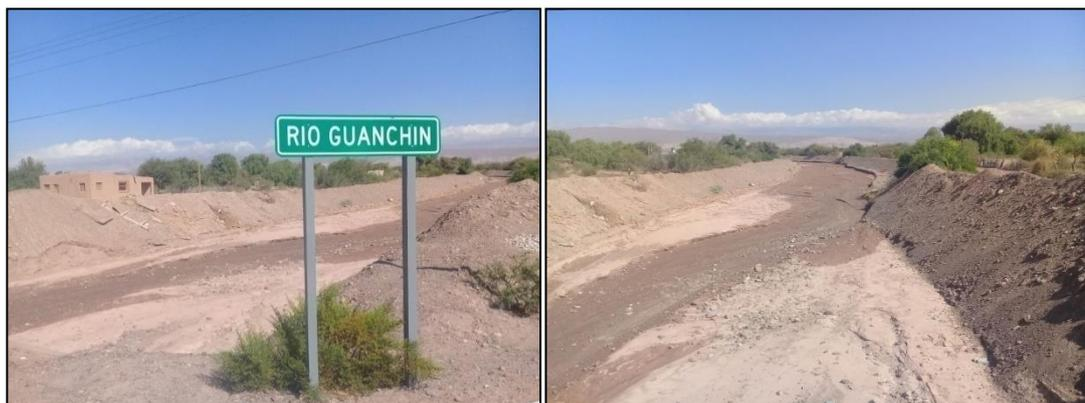
Figura N° 72 y Figura N° 73: Margen oeste del Río Chaschuil o Guanchin canalizado con materiales de su propio lecho.
