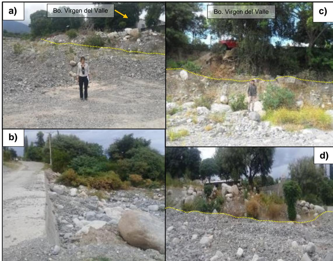
Imagen N° 27: a) vista aguas arriba del río Colana, se puede apreciar un incremento en el nivel de base, debido a un escaso mantenimiento del cauce. b) vista aguas abajo del río, en donde se profundiza la caída del río tras su paso por el badén. En las imágenes c) y d) se aprecia el estado del talud sobre el cual se emplaza el barrio, afectado por socavación lateral.
