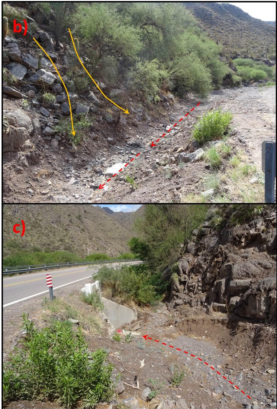
a) Quebrada Natural, y desviación de los afluentes. b) Desviación del curso de agua y material suelto disponible para deslizamiento con posible obstrucción de canal. c) Canal de derivación hacia Alcantarilla.
