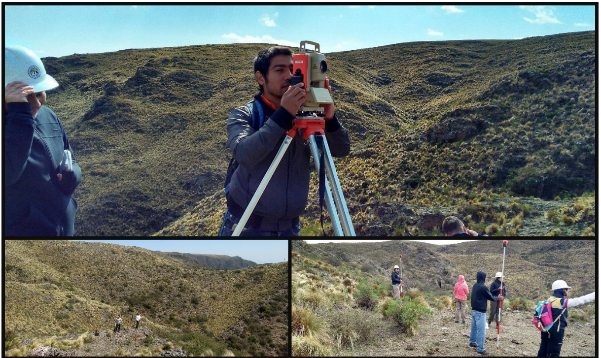
Imagen N° 5: Levantamiento topográfico con estación total.
