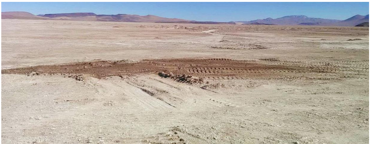
Foto 3: cierre de calicata
