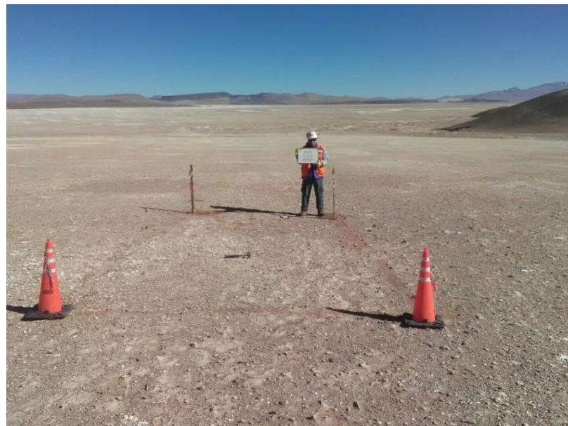
Foto 1: Apertura de calicatas
