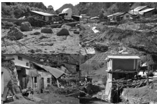
< Figura 1. Afectación de viviendas por el arrastre de sedimentos.
