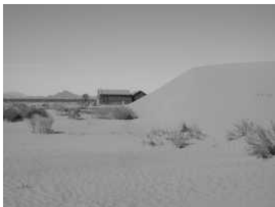
Fotografía 8. Riesgo eólico por avance de dunas para la vivienda.
