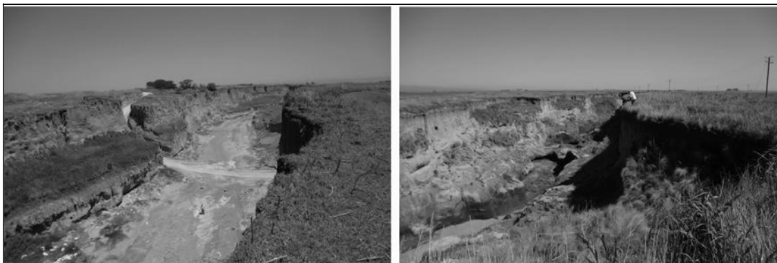
Figura. 6. A la izquierda se observa un nivel de terraza. A la derecha se observa la irregularidad interna de la cárcava.
