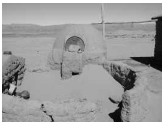
Fotografía 6. Acumulación de arena en vivienda ubicada en proximidades frente de avance.
