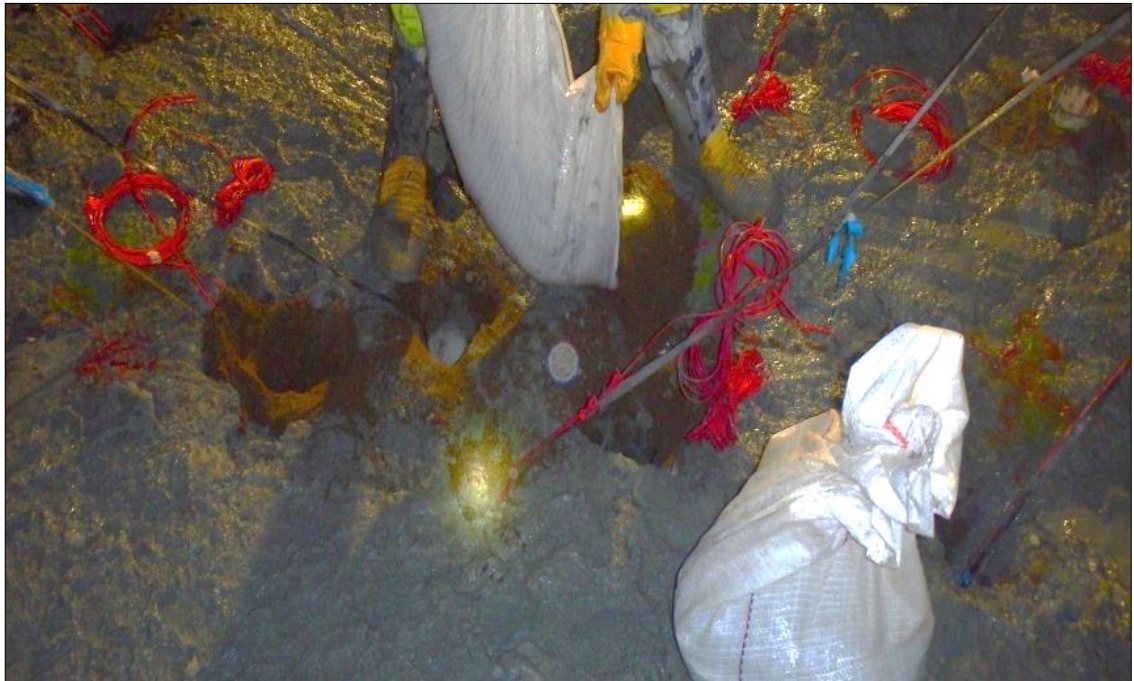
Imagen 8: Colocación de taco superior
