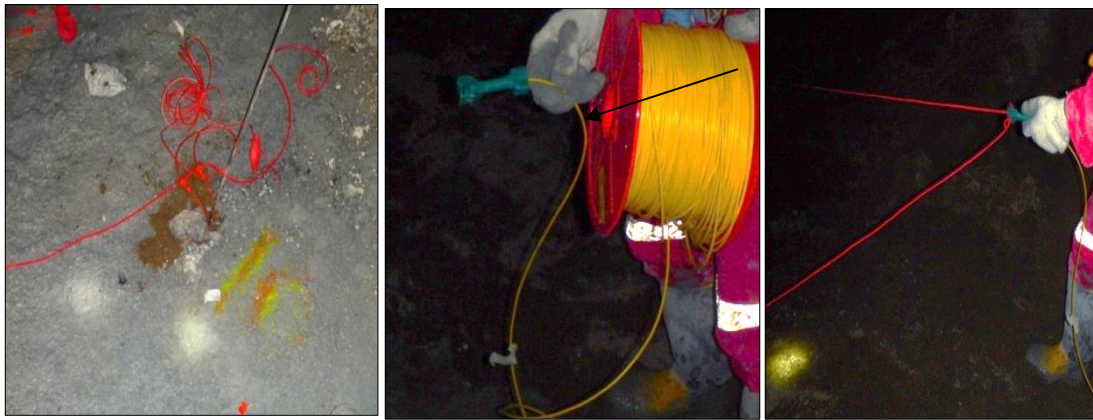
Imagen 9: Secuencia colocación del cordón más el lip.
