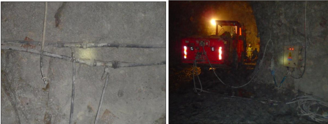
Imagen 1: Instalación de los servicios
