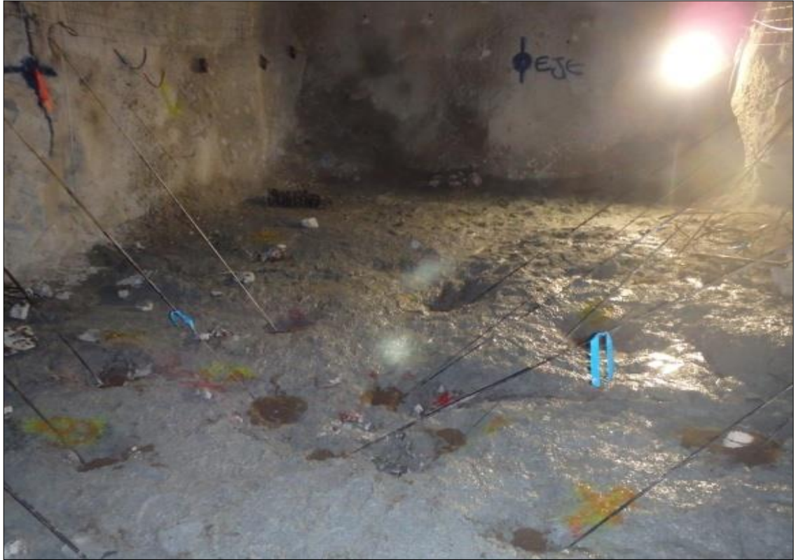
Imagen 4: Colocación de flejes en la chimenea
