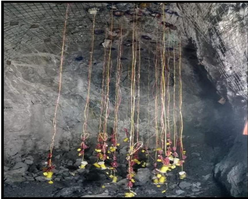
*Imagen 34: Carga de chimenea en forma ascendente.*
