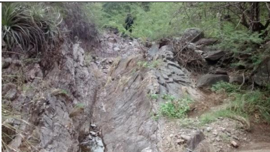
Foto 40: Tramo al inicio del colector, sobre basamento.
