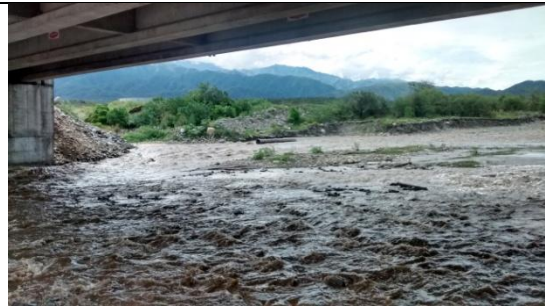
Foto 6: Vista debajo del puente de ingreso.
