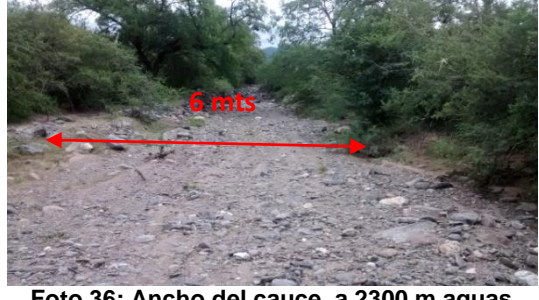
Foto 36: Ancho del cauce, a 2300 m aguas arriba de Alcantarilla 1.
