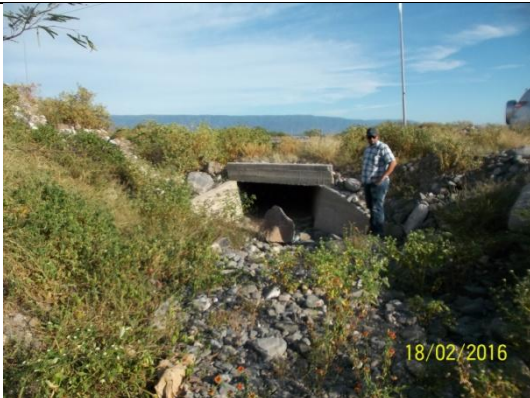
Foto 13: Alcantarilla 1 en Avenida 2, vista desde aguas arriba.
