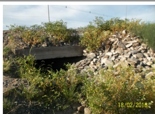
Foto 14: Alcantarilla 1, salida aguas abajo.
