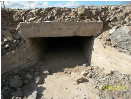
Foto 23: Alcantarilla 3 zona de descarga.
