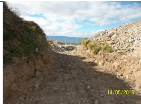
Foto 24: Vista del cauce aguas arriba de Alcantarilla 3.
