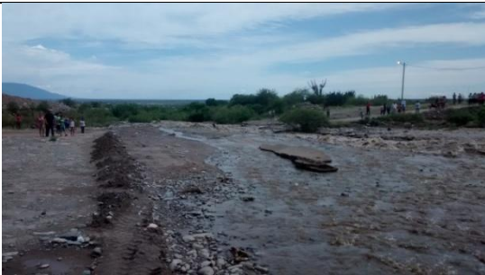
Foto 5: Terraplén Sur erosionado por la corriente.
