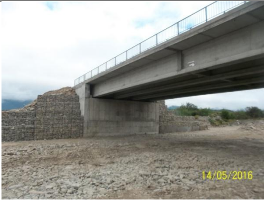
Foto 11: Gaviones margen Oeste, vista desde el Norte.
