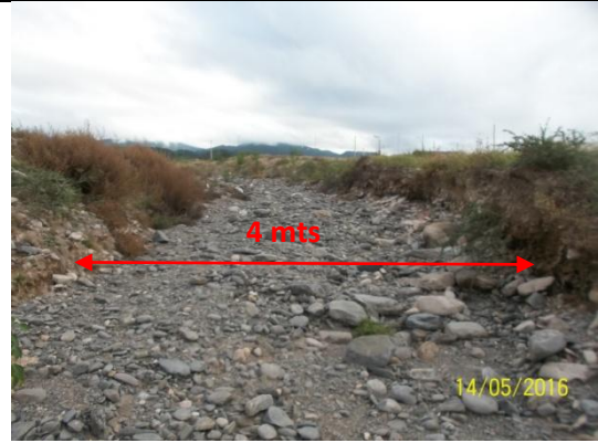
Foto 18: Canal A, vista NO-SE.
