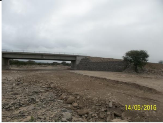
Foto 9: Puente 1, gavión sobre estribo y terraplén del margen Este, vista desde el Sur.
