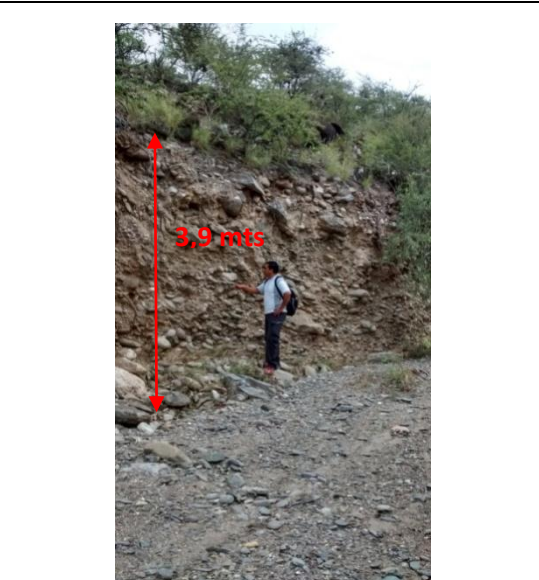
Foto 38: Talud natural observado durante el relevamiento. (Formación Coneta)
