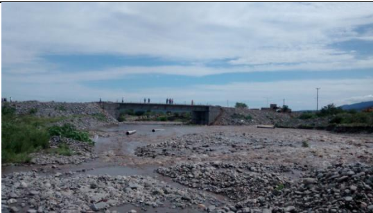
Foto 3: Vista Norte a Sur, puente sobre ingreso principal.
