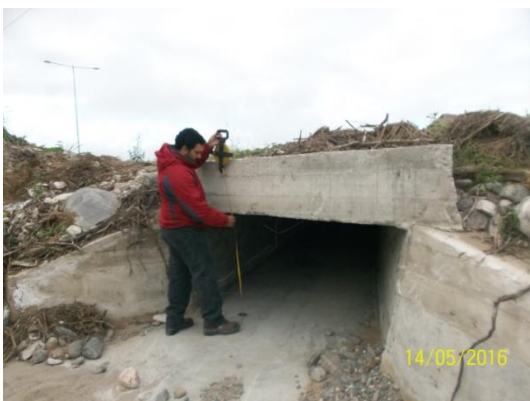
Foto 15: Vista Norte, Alcantarilla 1.
