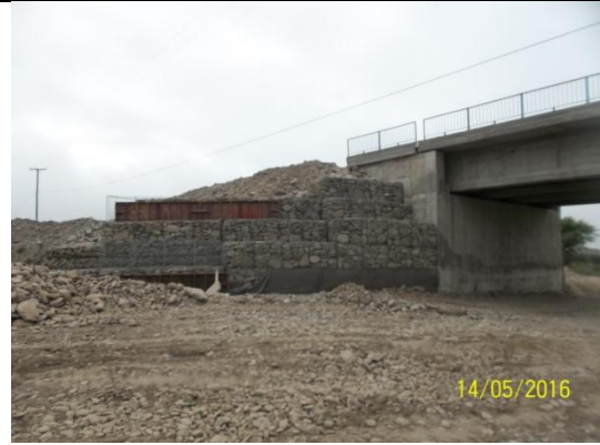
Foto 10: Puente 1, gavión sobre estribo y terraplén del margen Oeste, vista desde el Norte.
