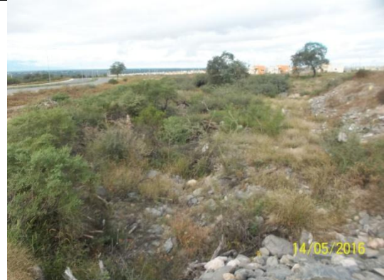
Foto 22: Paleocauce, aguas abajo de Alcantarilla 1.
