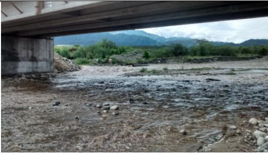
Foto 1: Vista del puente principal durante aumento de caudal del río.
