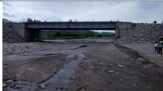
Foto 4: Vista Norte, puente sobre ingreso principal.
