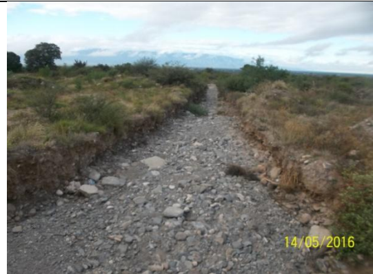
Foto 20: Canal B aguas abajo de Alcantarilla 2.
