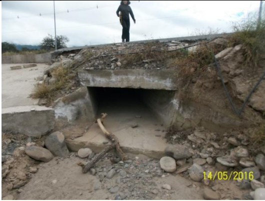
Foto 17: Alcantarilla 1, salida aguas abajo.
