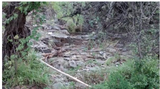
Foto 41. Tramo al inicio del colector.
