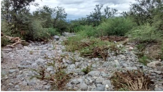
Foto 33: Zona de cambio de pendiente, a 700 m aguas arriba de Alcantarilla 1.
