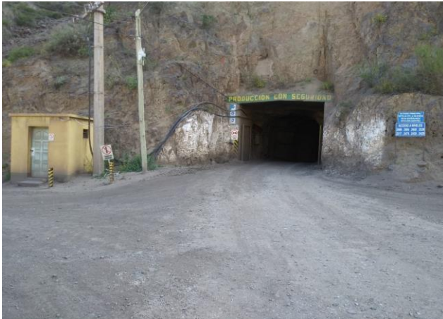
Imagen 7: Ingreso de Rampa Principal
