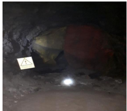
Imagen 24: Cerramiento deteriorado.
