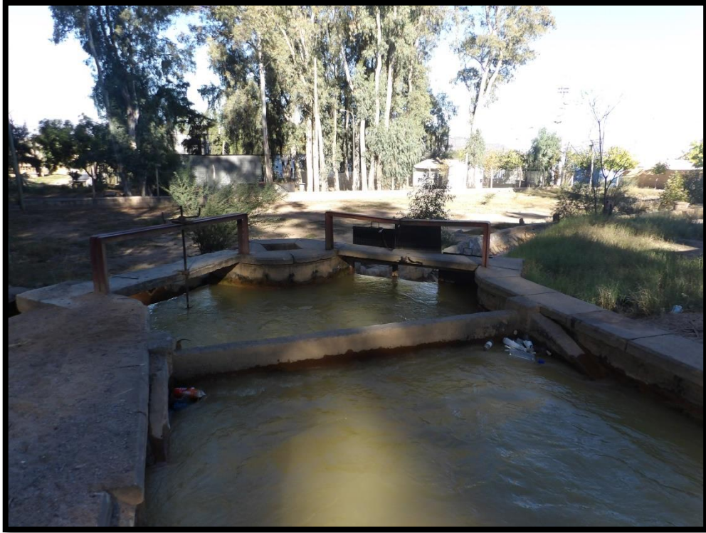
Figura 3.3 Partidor “El Parque”. Módulo Primario y distribución Secundaria en margen izquierda y derecha respectivamente.
