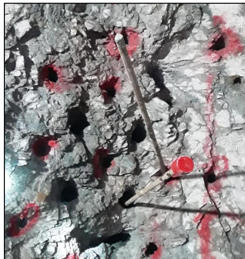
Figura 39. Control de paralelismo de perforación
