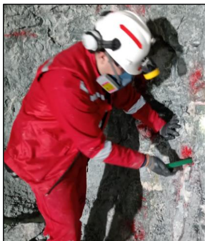
Figura 37. Verificación de longitud de perforación mediante taqueador
