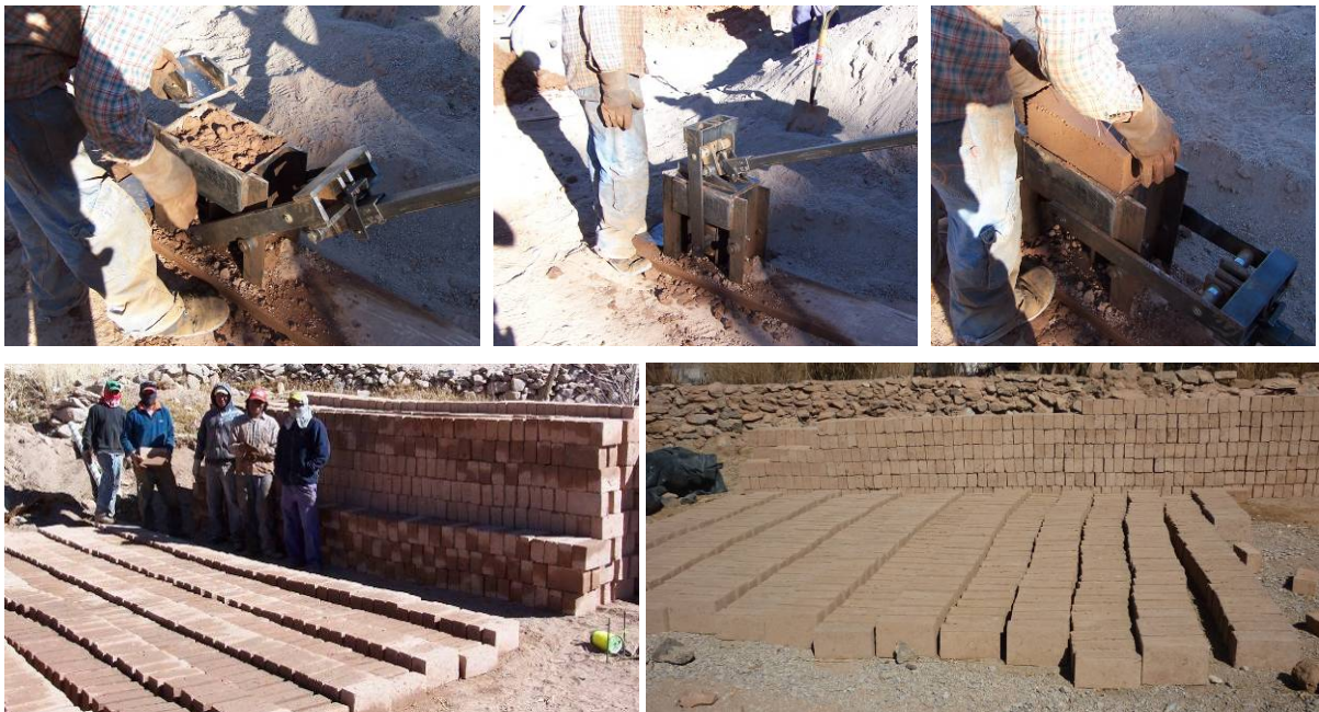
Figuras 3-4- 5- 6 y 7- Fotografías del proceso de construcción de los bloques con CINVA-RAM.
