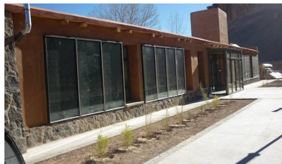
Figura 18 Fotografía muro trombe e invernadero
