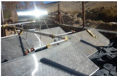
Figura 19 Colector solar plano y tanque
