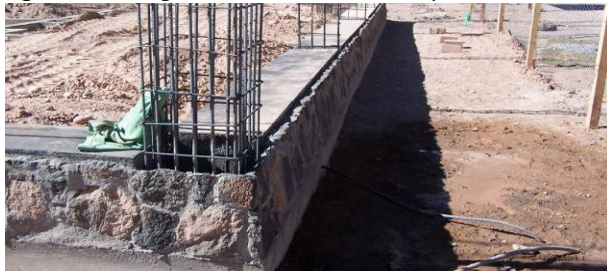
Figura 11 Fotografía sobre-cimiento de piedra
