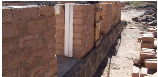
Figura 12 Fotografía mampostería doble c/aislación
