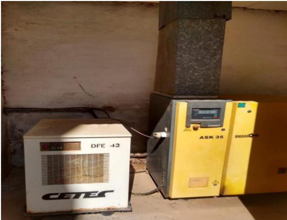
Compresor Modelo Kaeser ASK35. Compresor helicoidales de tornillo seco.
