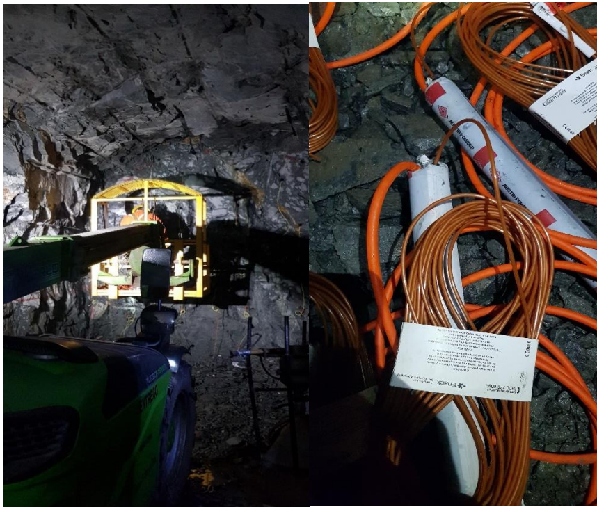
Figura 41: Carga de explosivo en el frente de trabajo
