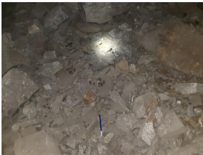
Figura 38: Fragmentación de la voladura – resultados post voladura –Diagrama estándar sección 3.8 m x 3.8 m
