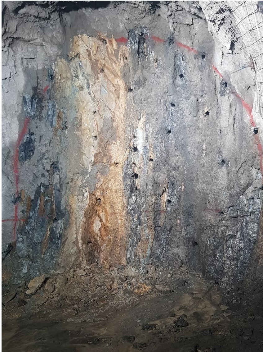
Figura 37: Diagrama estándar perforado-Sección 3.8 m x 3.8 m
