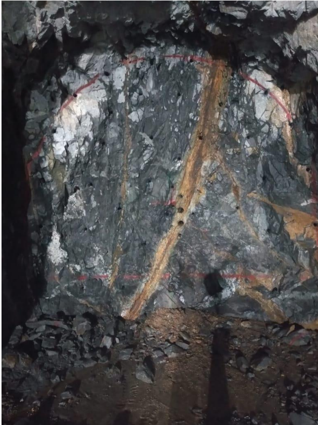
Figura 47: Diagrama estándar perforado- sección 4.1 m x 4.1 m
