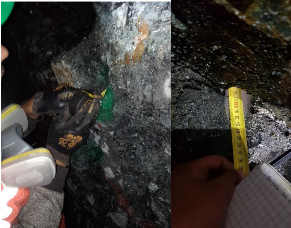
Nota: Se observa la medición de los taladros mediante la cinta métrica, para tener un control de la longitud de perforación
