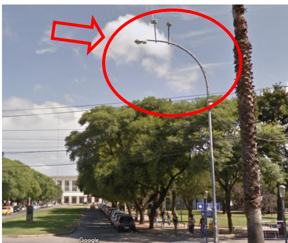
FIG. 10. ANTENAS UBICADAS EN LA VÍA PÚBLICA. FUENTE: [10].
