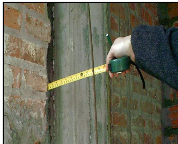
Foto 11.18. Estructura de H° A° de la Parcela 32a
