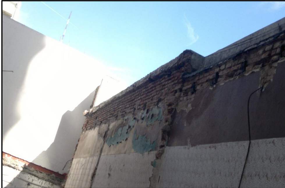
Foto 5.3.2. Muro de de Mampostería
