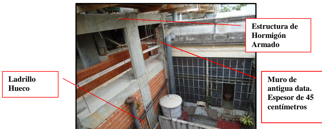
Foto 5.5.3. Estructura de Hormigón, empotrado en Muro Medianero
