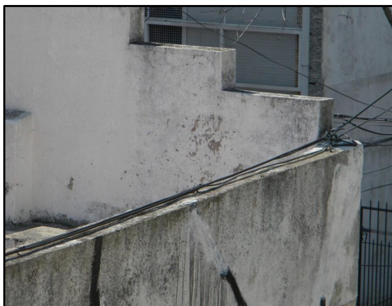
Foto 5.3.1. Muro de Parapeto en Azotea
