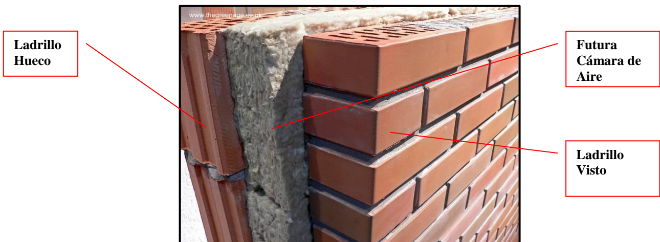
Figura 5.5.4. Muro con cámara de aire. Fuente: http://www.sistematicasa.com.ar
