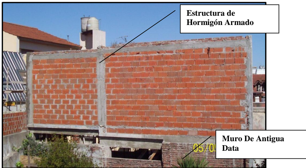
Foto 11.8. Vista del muro y estructura construido por lindero 25
