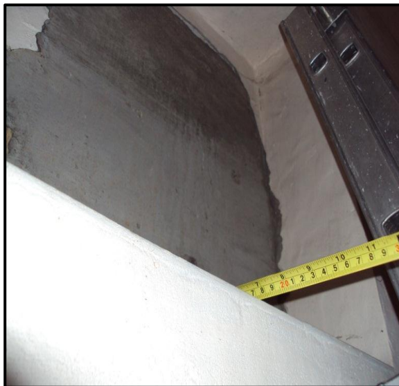
Foto 11.20. Columna construida por Parcela 28
