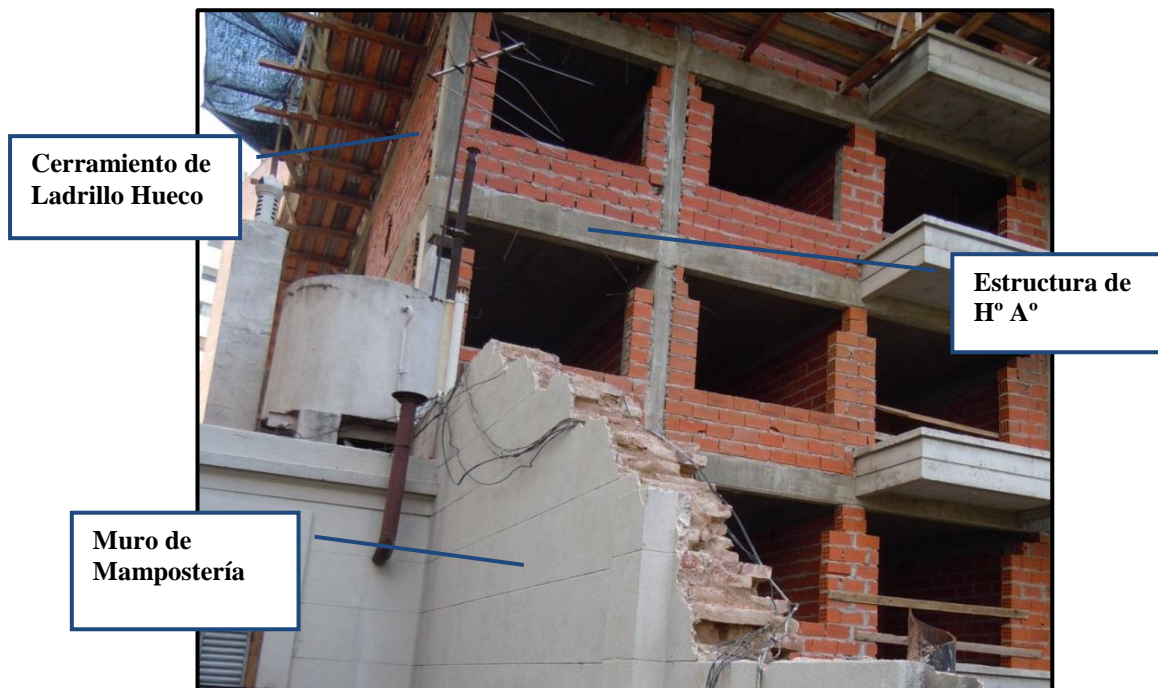
Foto 5.4.1. Muro de de Mampostería y Edificio con Estructura de H° A°
