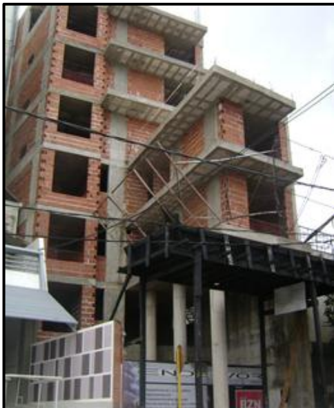
Foto 5.5.1. Edificio con Estructura de H° A°
