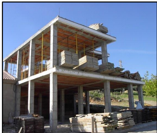
Foto 5.5.2. Estructura de H° A°
