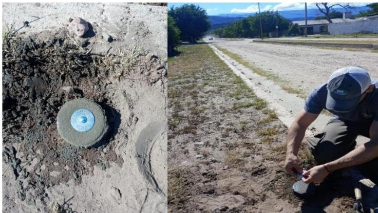
*Figura N°4. Construcción del respectivo mojón. Fuente: elaboración propia.*
