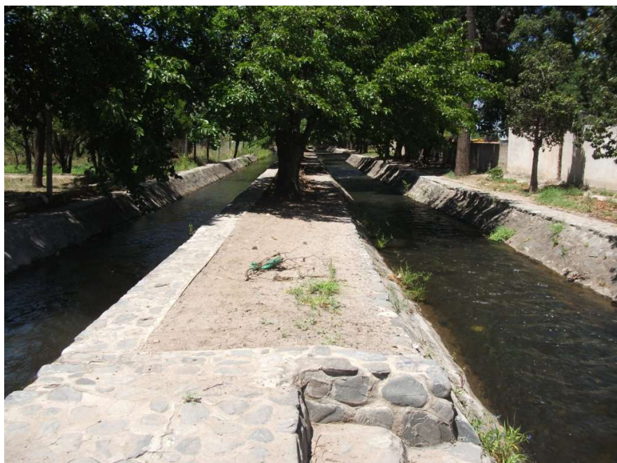
Canales de riego. Depto. Fray Mamerto Esquiú. Fuente F.R. Palacios
