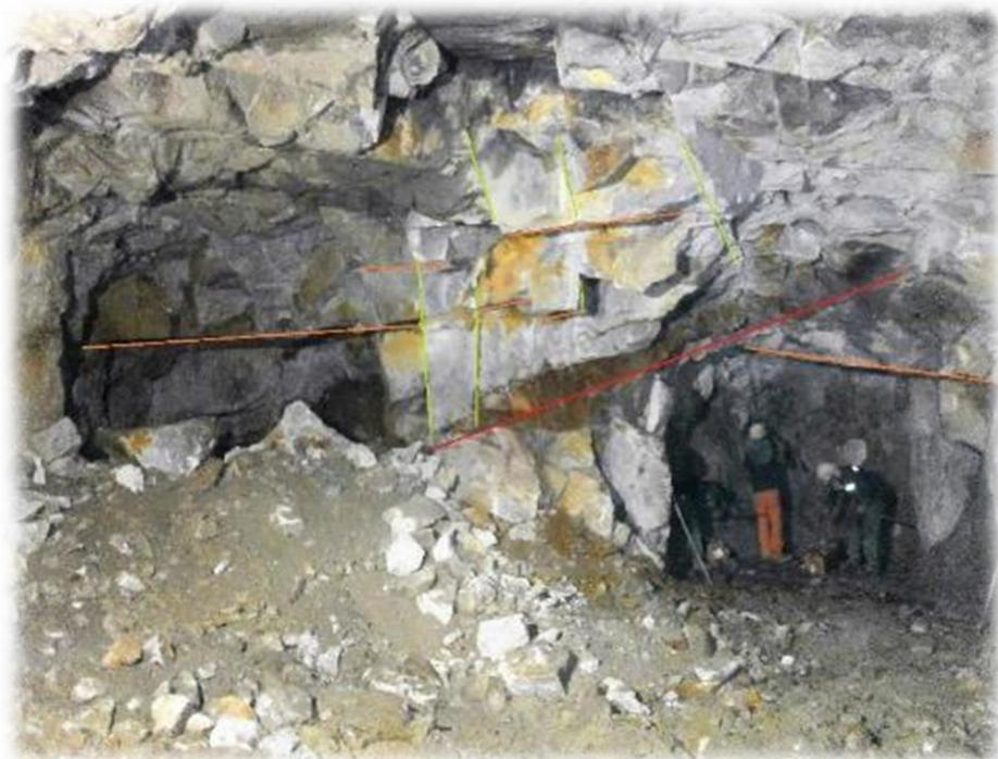
Imagen 24 Sector de labor con dimensión 11m x 5 m progresiva 70 m. Macizo rocoso con fracturamiento en bloques; presencia de humedad.
