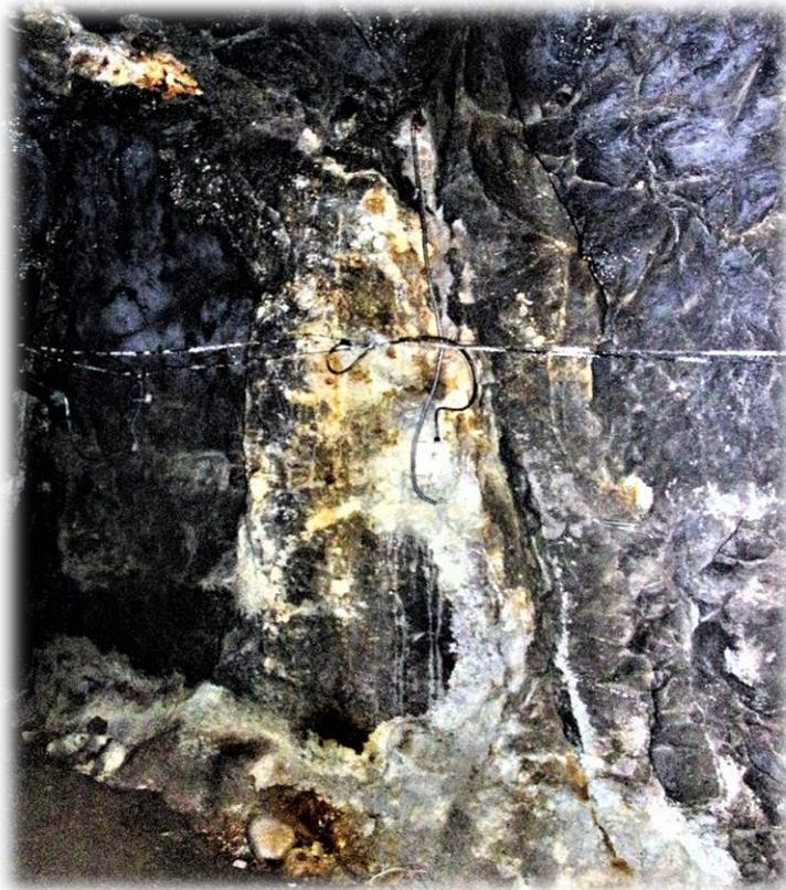
Imagen 22 Hastial falla interceptando en el hastial izquierdo (progresiva 128m).
