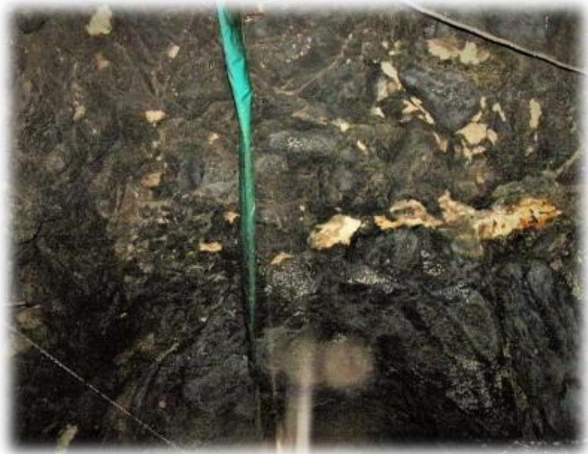
Imagen 21 sector de falla atravesando la corona (progresiva 124 y 128m), se observa goteo en la corona con superficies claras que corresponden a desprendimientos recientes.
