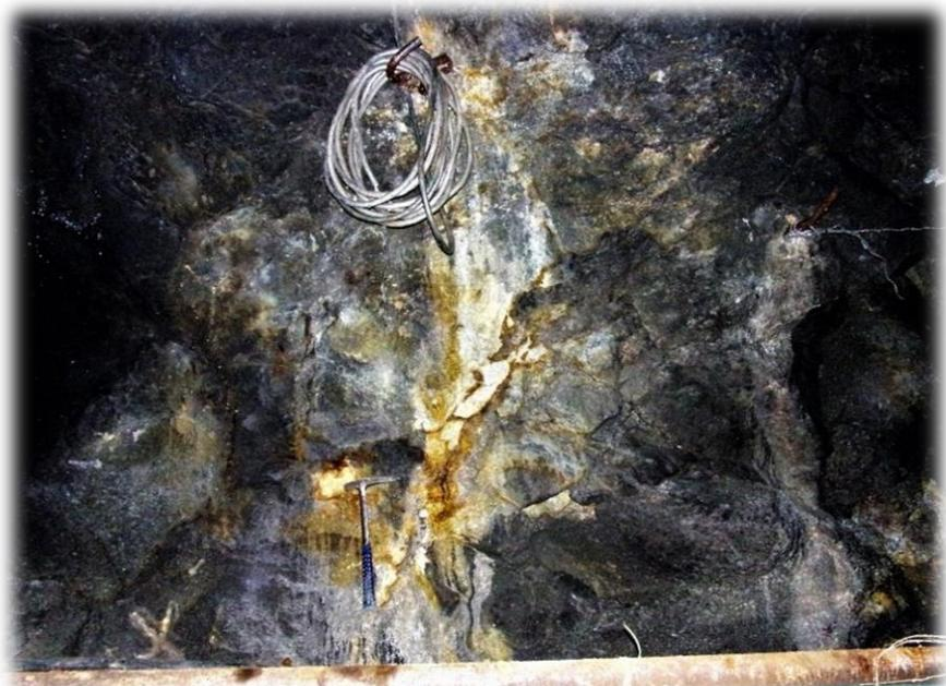
Imagen 20: Hastial derecho inicio de falla progresiva 124, roca muy alterada con presencia abundante de arcilla, limonita y óxidos (ocres).
