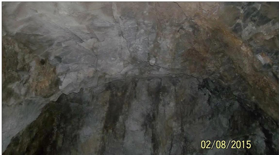
Imagen 29: material sin desprenderse en el techo - Prueba N° 2
