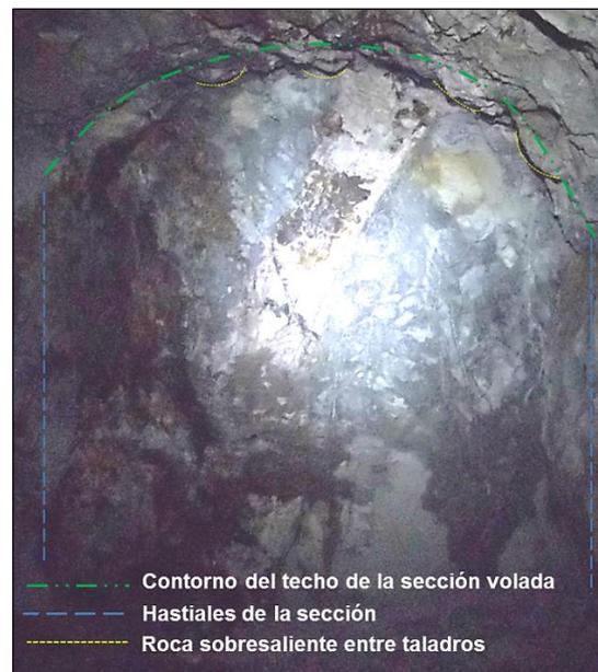
Imagen 17: Nuevo tope de perforación, luego de limpieza y tojeo – Prueba N° 4
