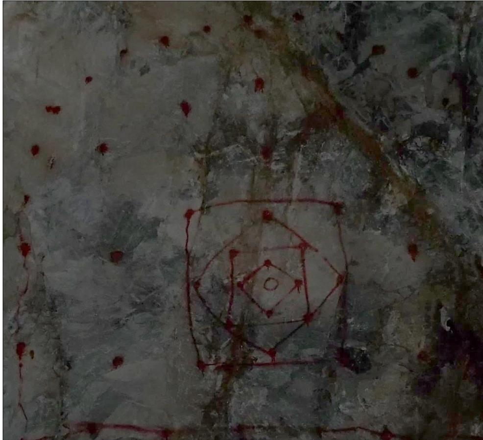
**Imagen 30:** Marcación de diagrama de perforación - Prueba Nº 2
