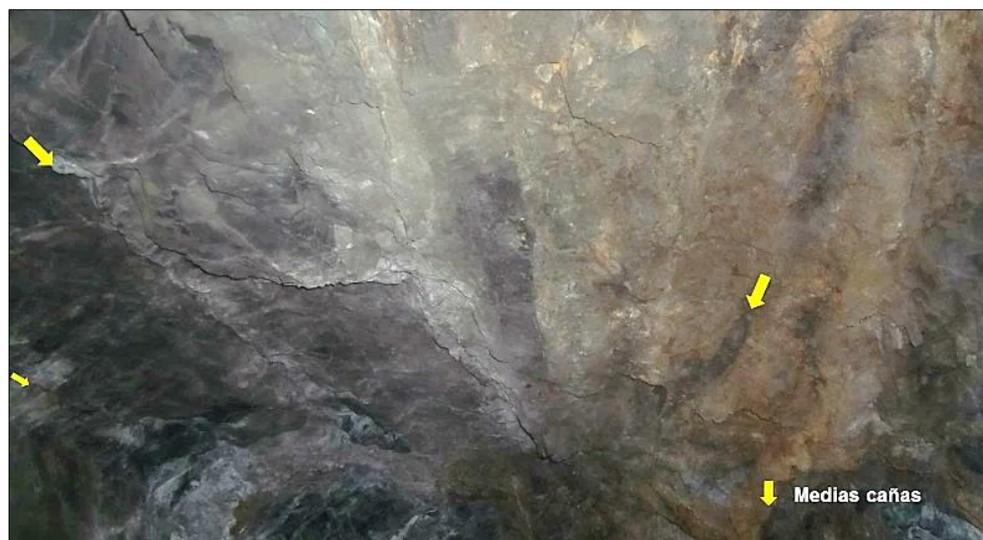
**Imagen 24:** Contorno final del techo – Prueba N° 8
