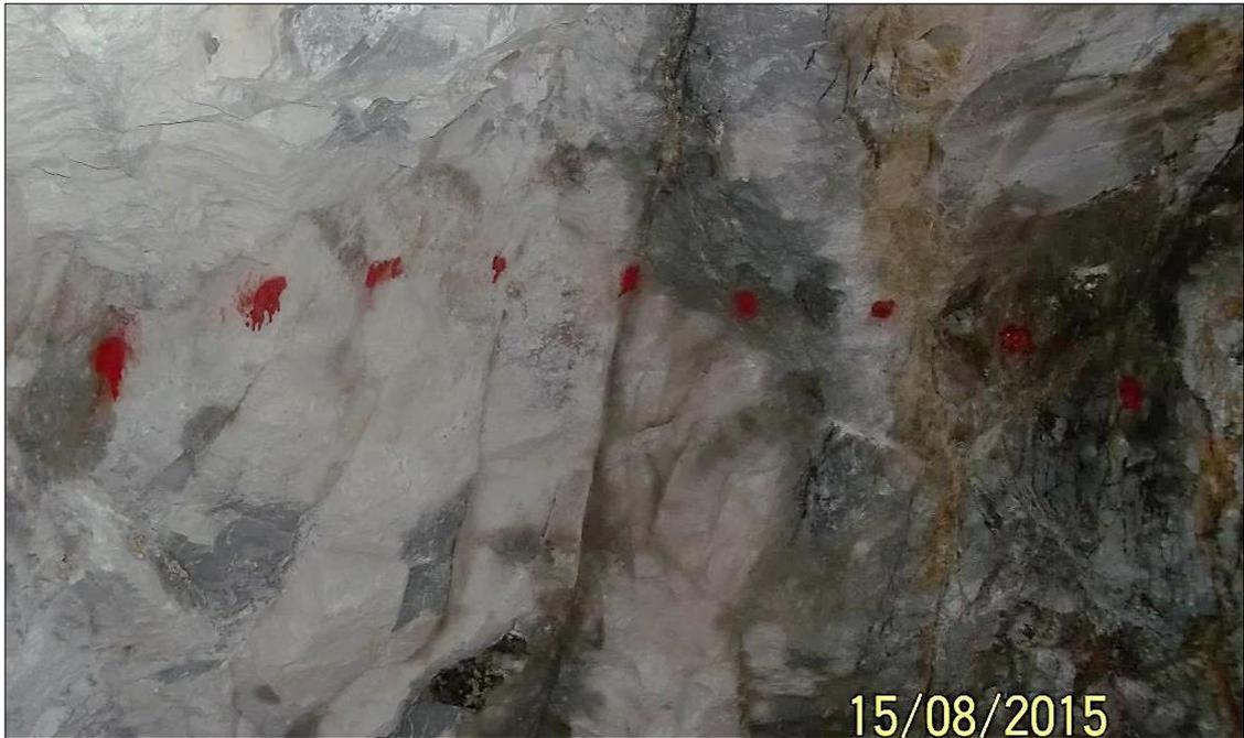
**Imagen 41:** marcación de puntos del precorte - Prueba N° 7
