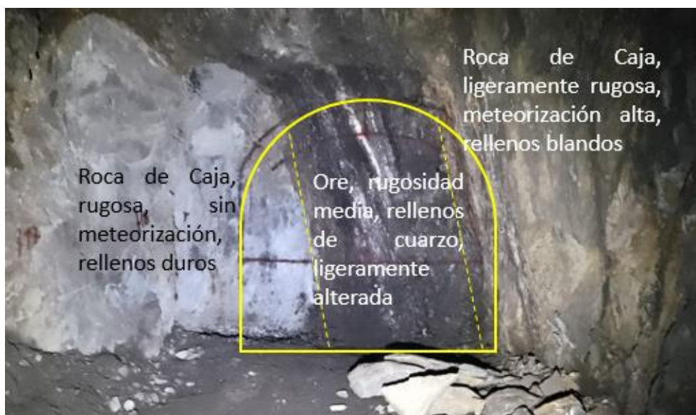
Ilustración 66: Frente de perforación N2390
