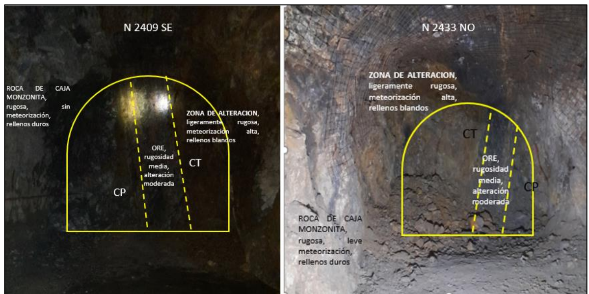
Ilustración 98: Estado de los frentes en N2433 Y N2409
