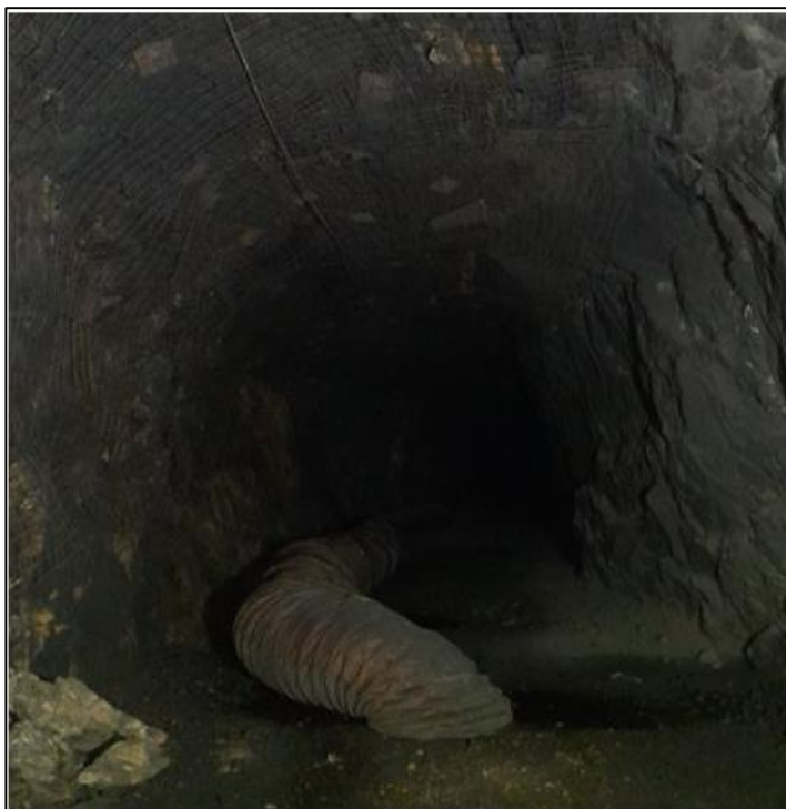
Ilustración 99: Presencia de agua producto de la perforación
